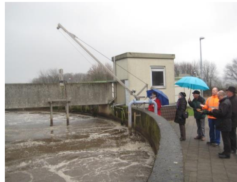
Schwachlastbelebungsbecken: Erläuterungen durch Herrn Breuer (ZKA)
